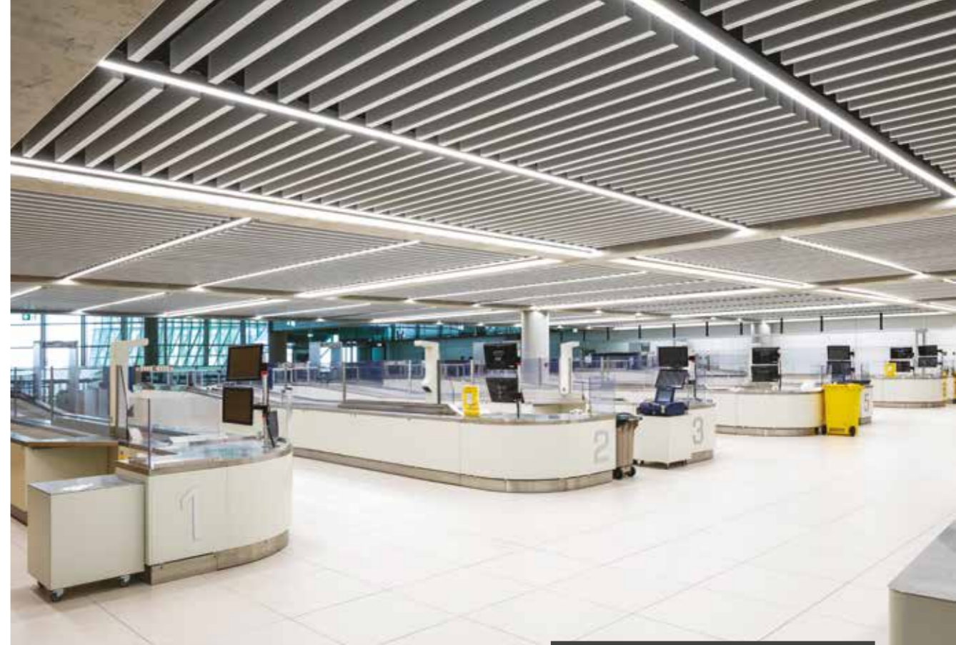
Вертикальные панели-экраны Armstrong Metal Baffles, перфорация Rd 1522, цвет RAL 9016
