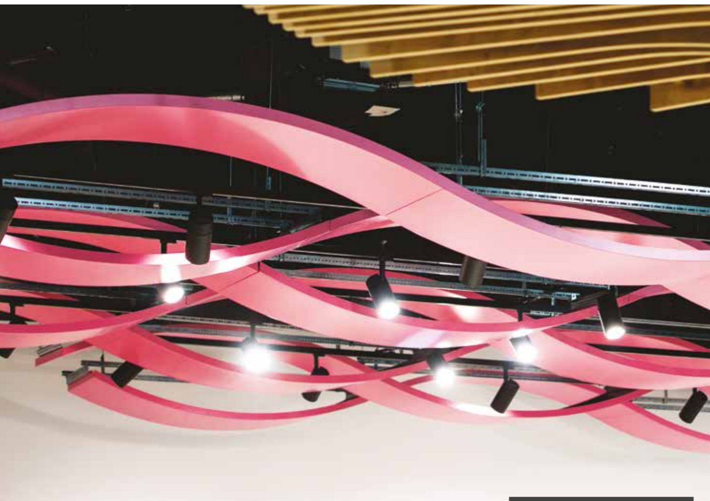
Нестандартное металлическое решение Armstrong R-H 200 (вогнутые и выпуклые панели), цвет RAL3015
