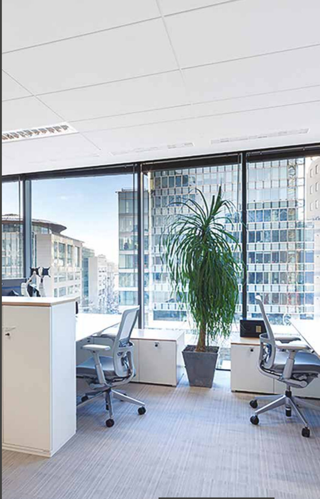
Дизайнерские ламинированные панели Armstrong с кромкой Tegular 15/90, профиль Armstrong Axiom 50 мм
