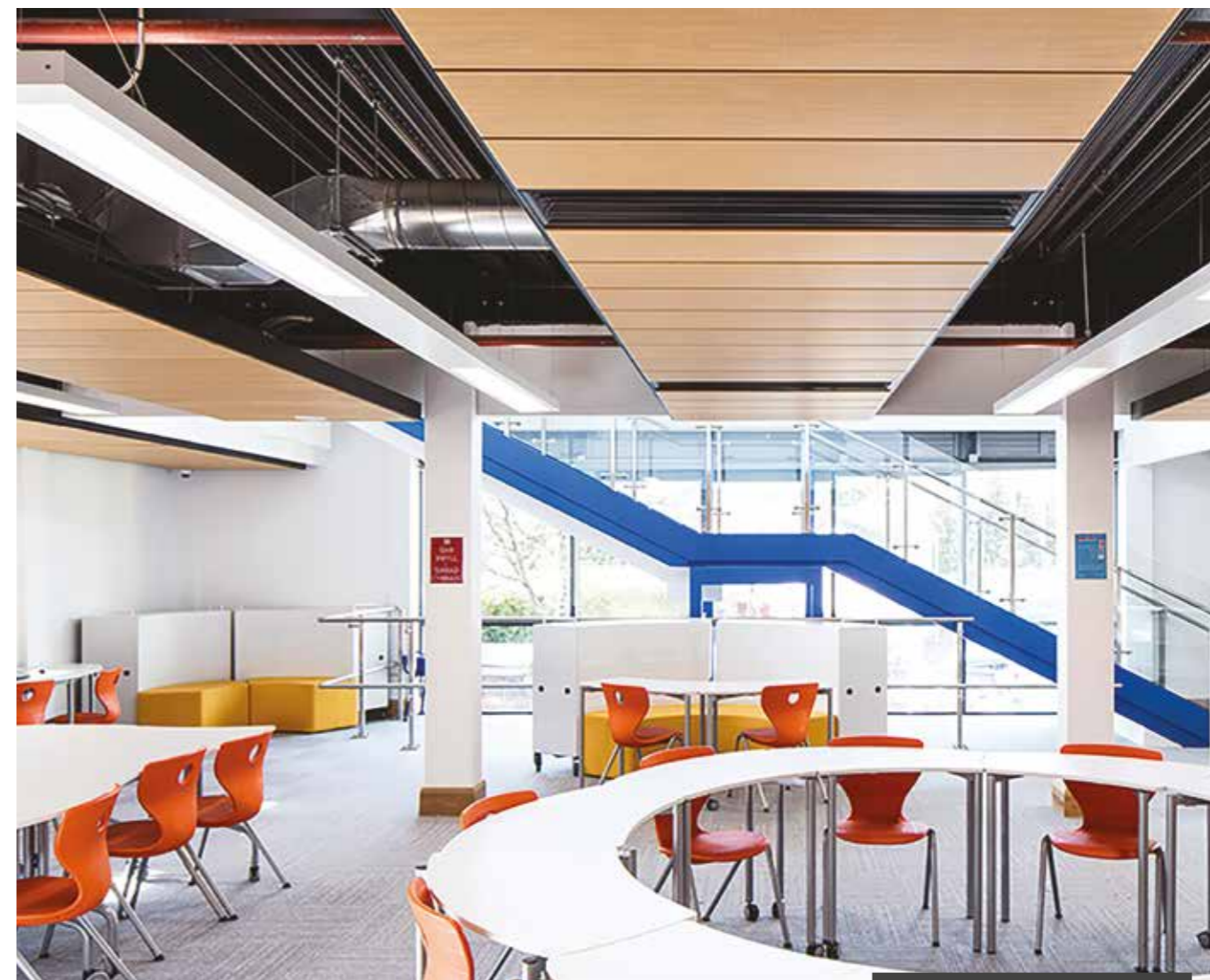
Металлическое потолочное решение Armstrong MicroLook 8 с отделкой под дуб, профиль Armstrong Axiom
