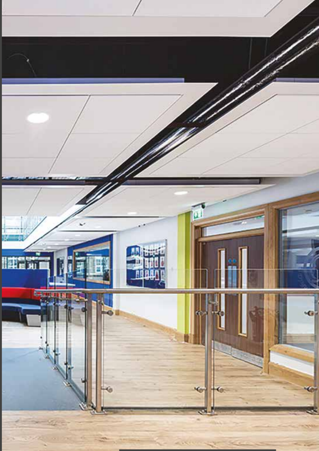
Потолки-острова Armstrong Axiom Knife Edge Canopy с заполнением дизайнерскими ламинированными панелями Armstrong с кромкой Vector
