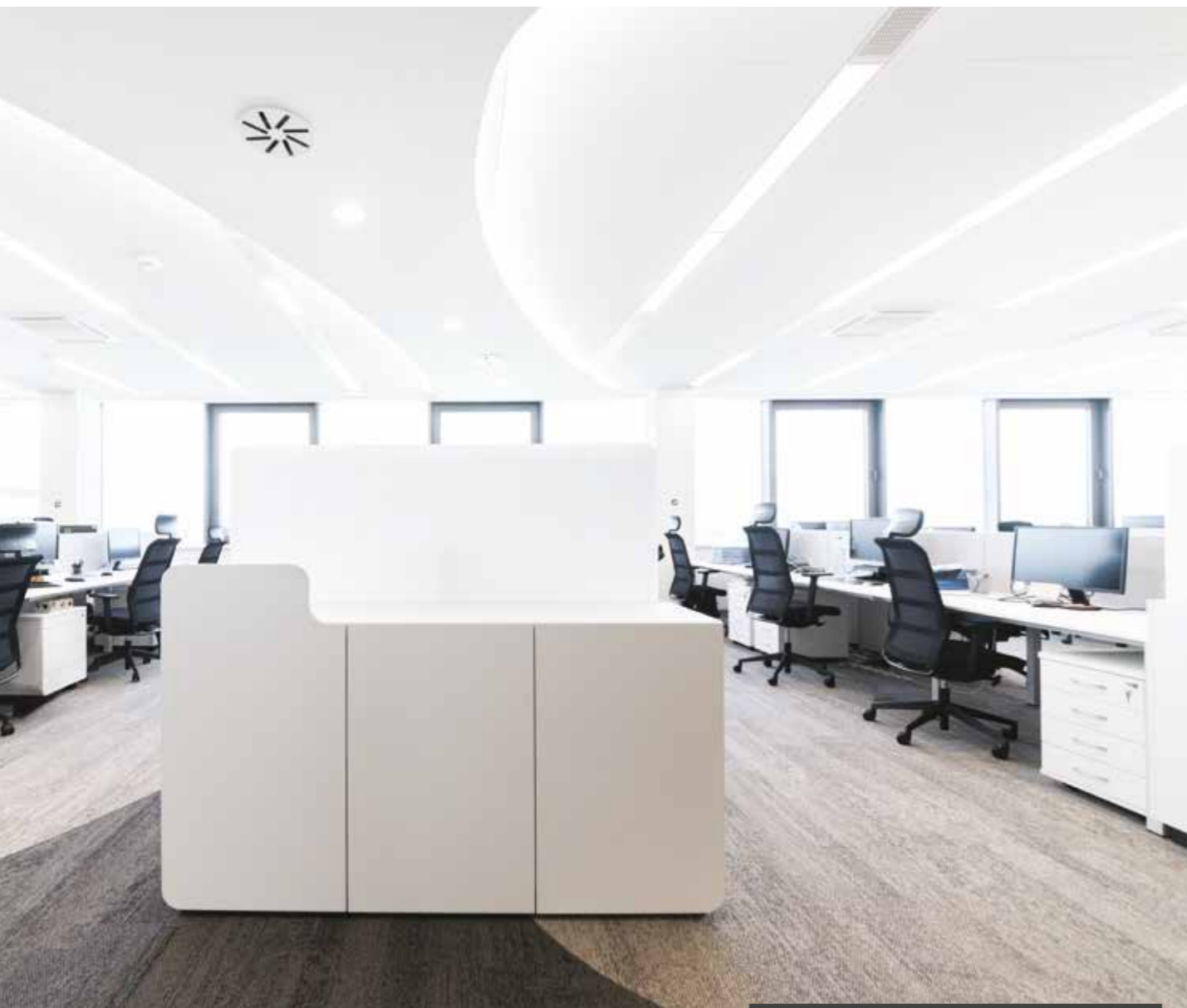
Потолочное решение конфигурации TechZone на основе дизайнерских ламинированных панелей Armstrong с кромкой SL2 и Tegular 15/90
