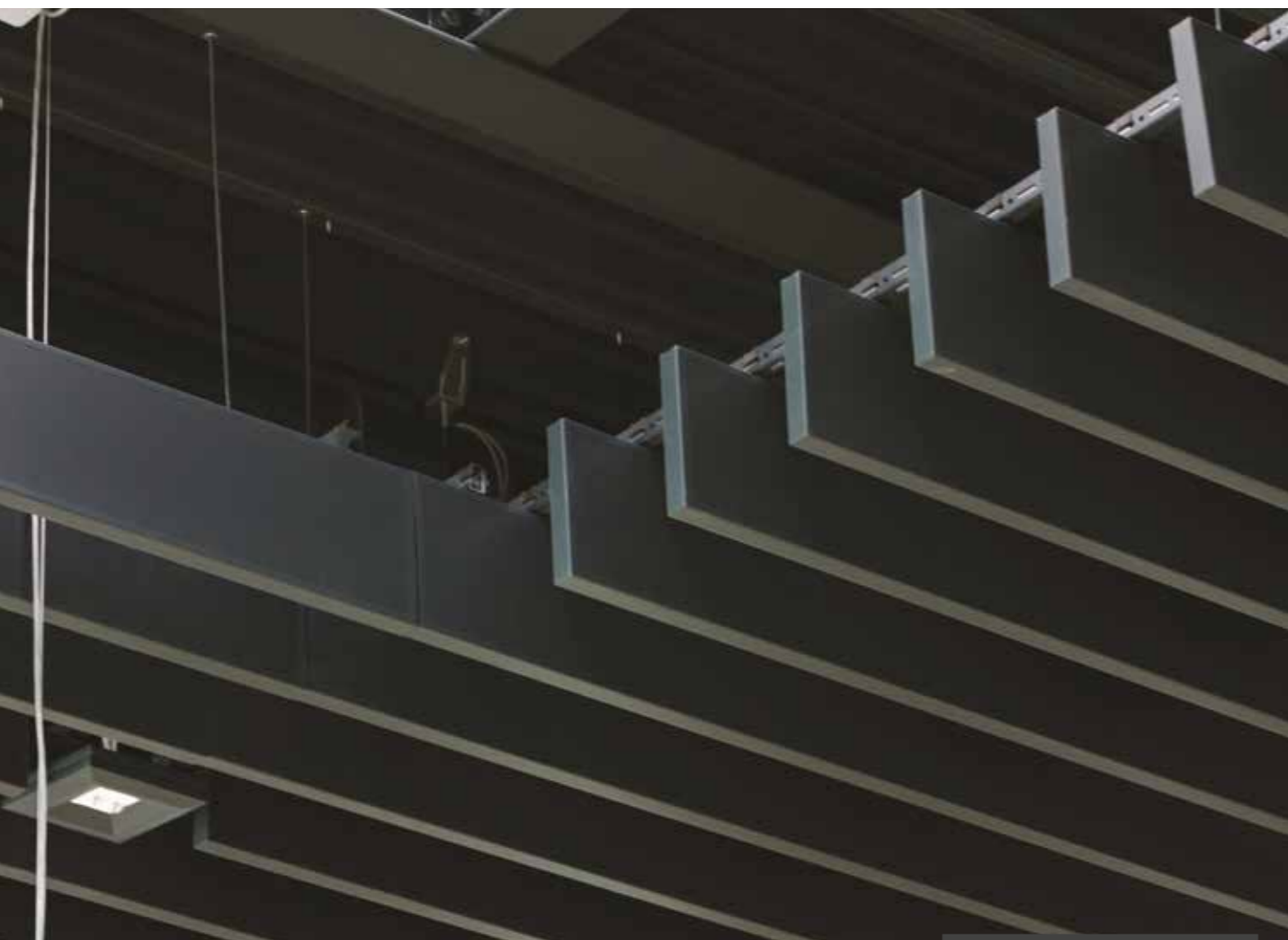
Вертикальные панели-экраны Armstrong Metal Baffles V-P 500, перфорация Rd 2535, цвет RAL 7016
