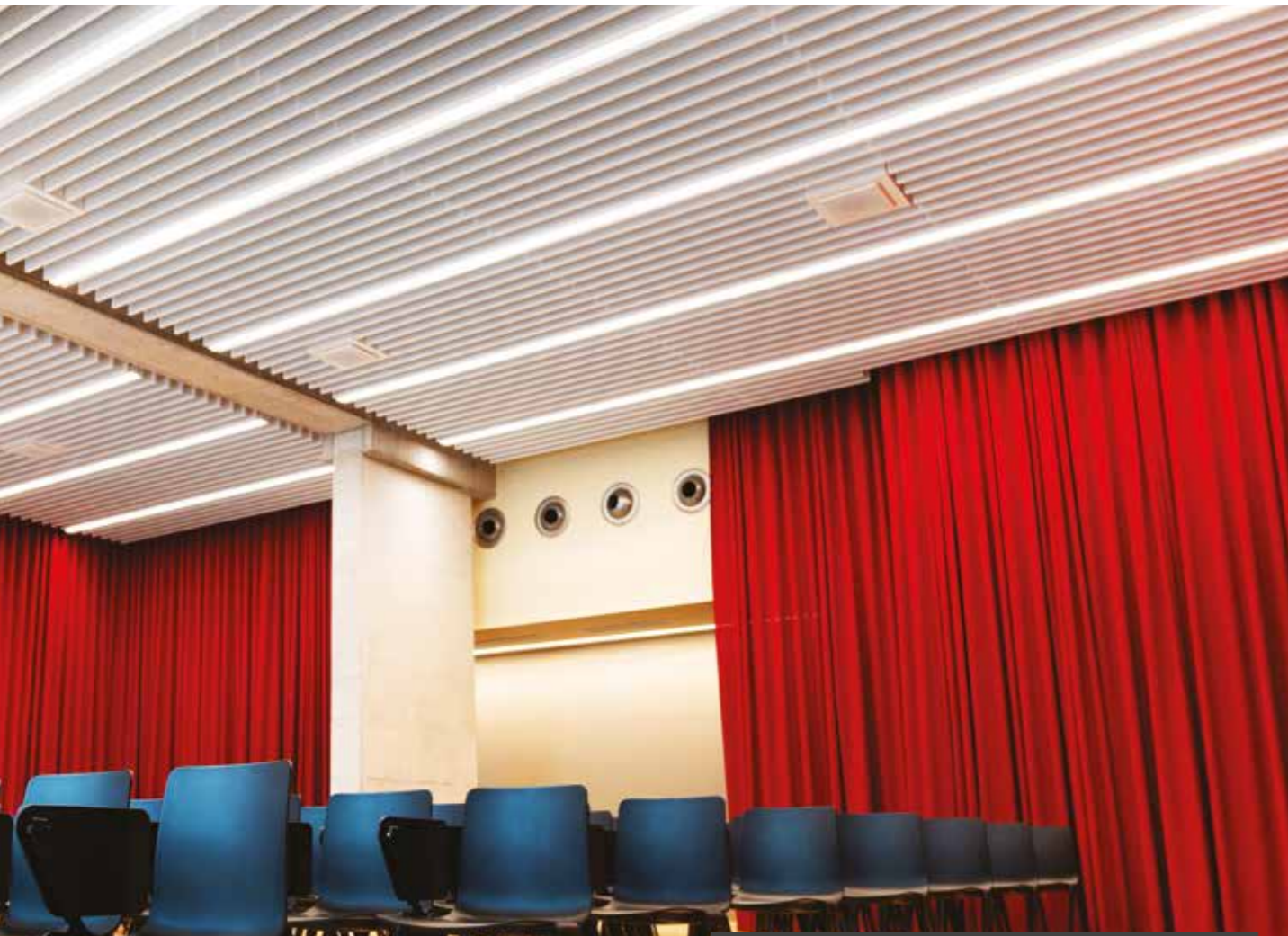
Вертикальные панели-экраны Armstrong Metal Baffles V-P 500, перфорация Rd 1522, цвет RAL 9016
