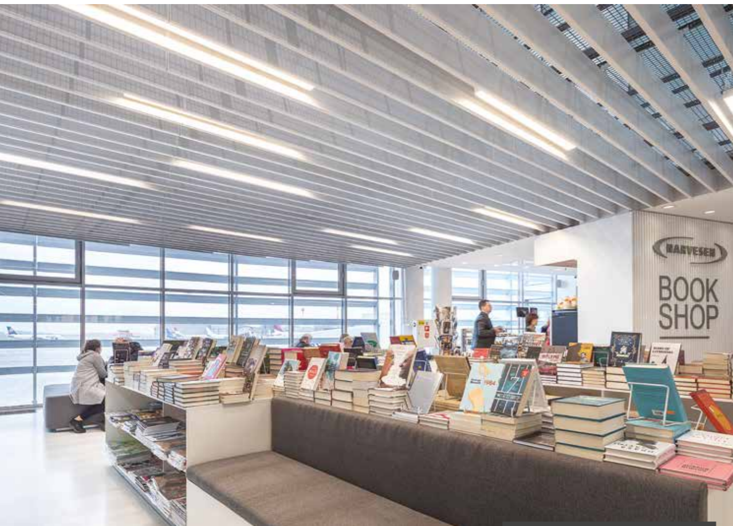
Вертикальные панели-экраны Armstrong Metal Baffles V-P 500, перфорация Rd 1522
