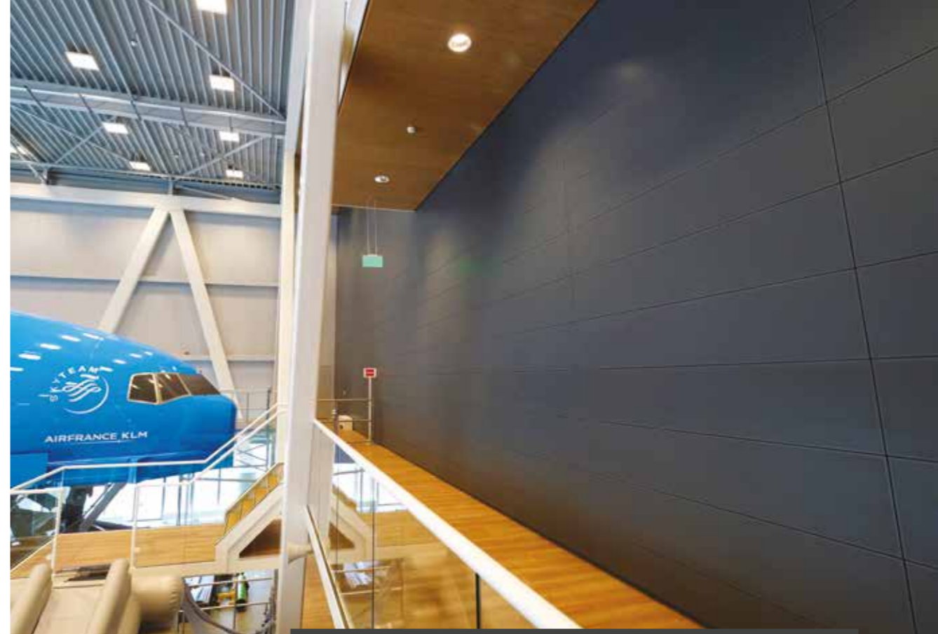
Металлическое потолочное решение Armstrong R-H 200, цвет «красный дуб» Стеновое решение Armstrong Metal W-H 1000, перфорация Rd 1522, цвет RAL 7023
