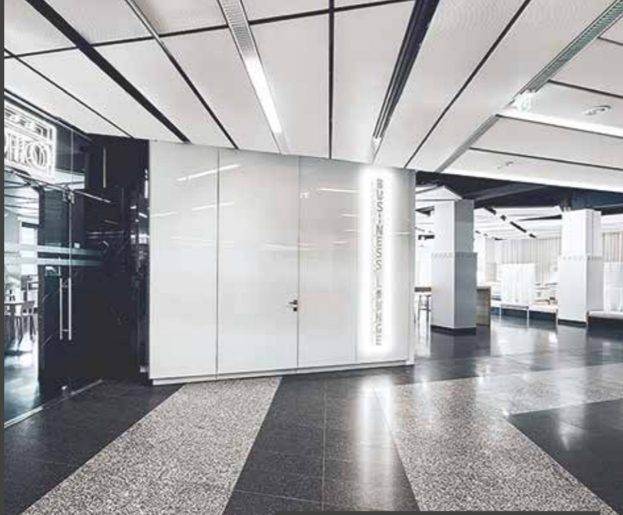
Нестандартное металлическое решение Metal R-Clip, перфорация Rg 3013, цвет RAL 1013
