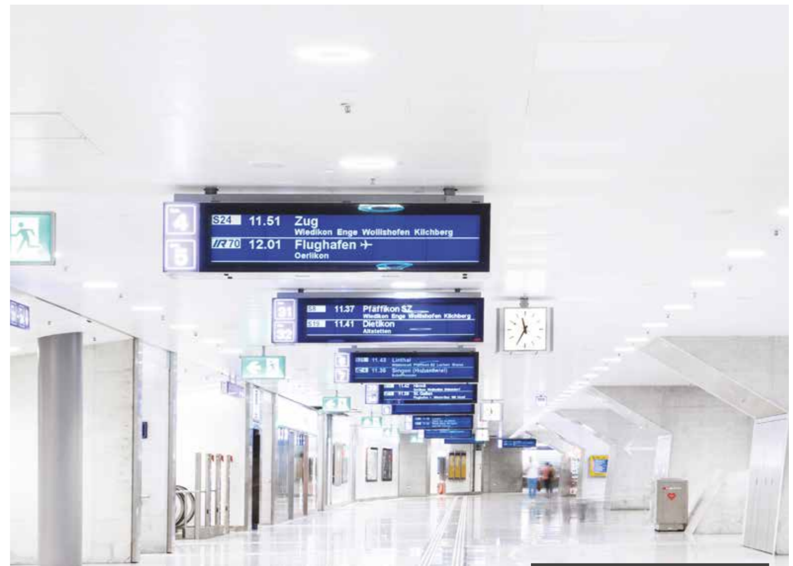
Металлическое потолочное решение Armstrong Q-Clip, перфорация Rd 1522, цвет RAL 9003
