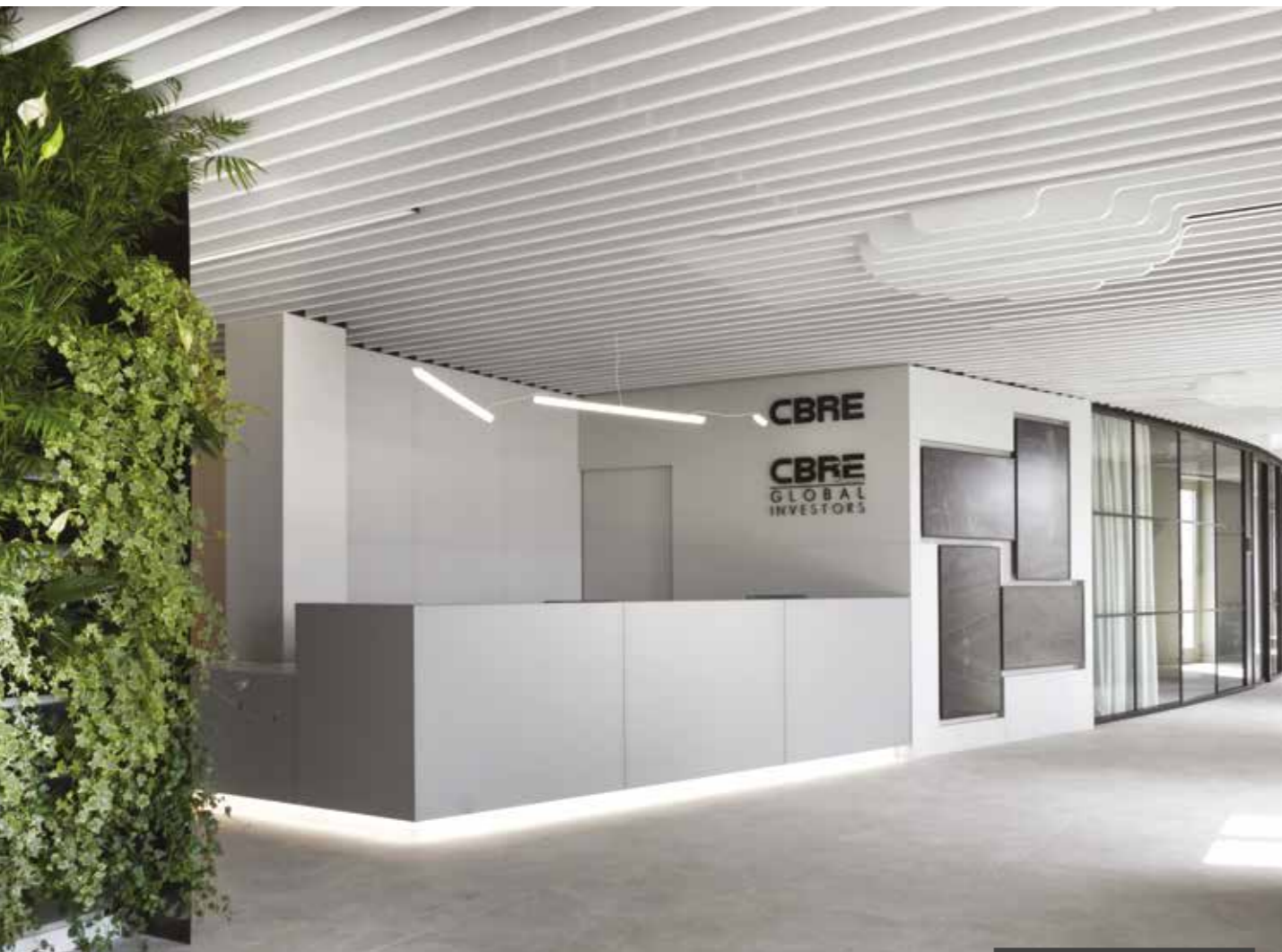
Вертикальные панели-экраны Armstrong Metal Baffles V-P 500 (индивидуальная форма)
