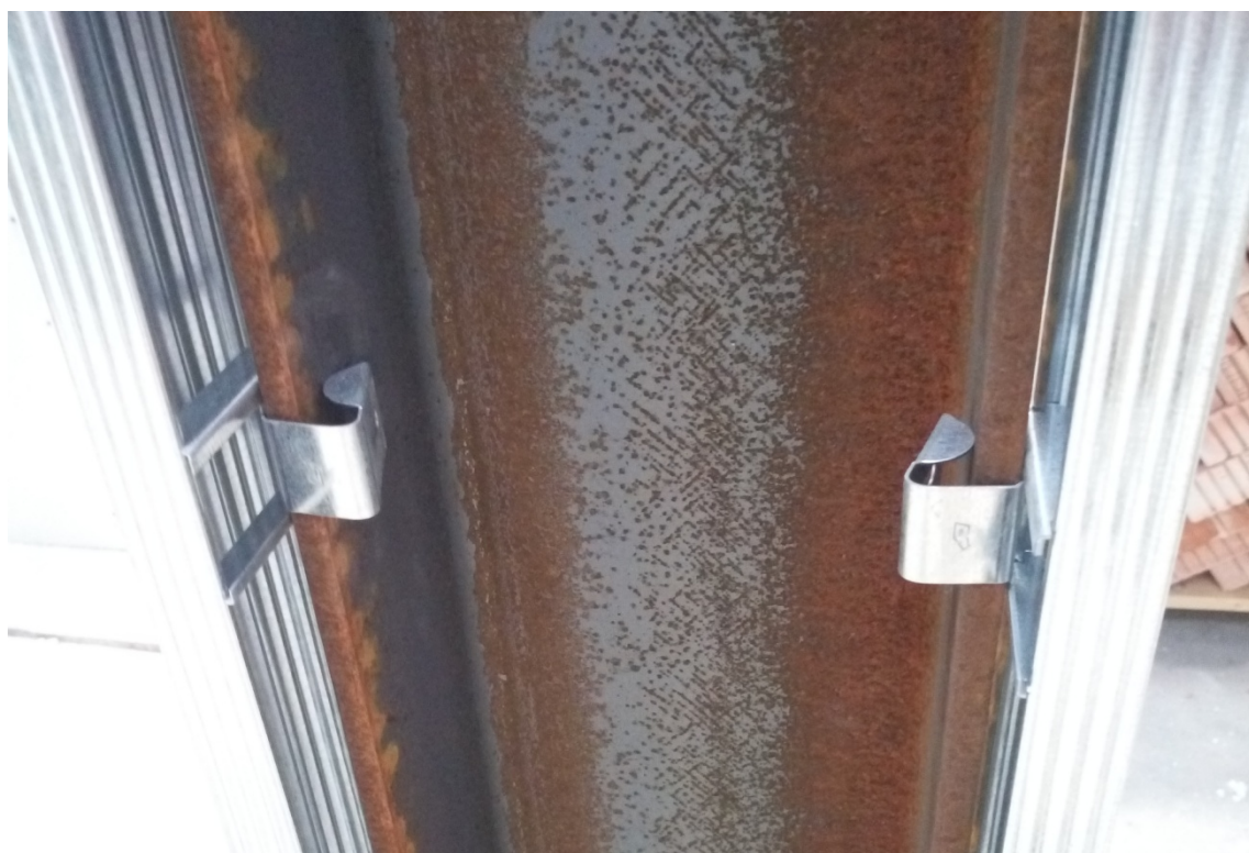
Рисунок 5. КНАУФ-профиль ПП 60/27 установленный на металлическую колонну с помощью зажимов 70x48x42
