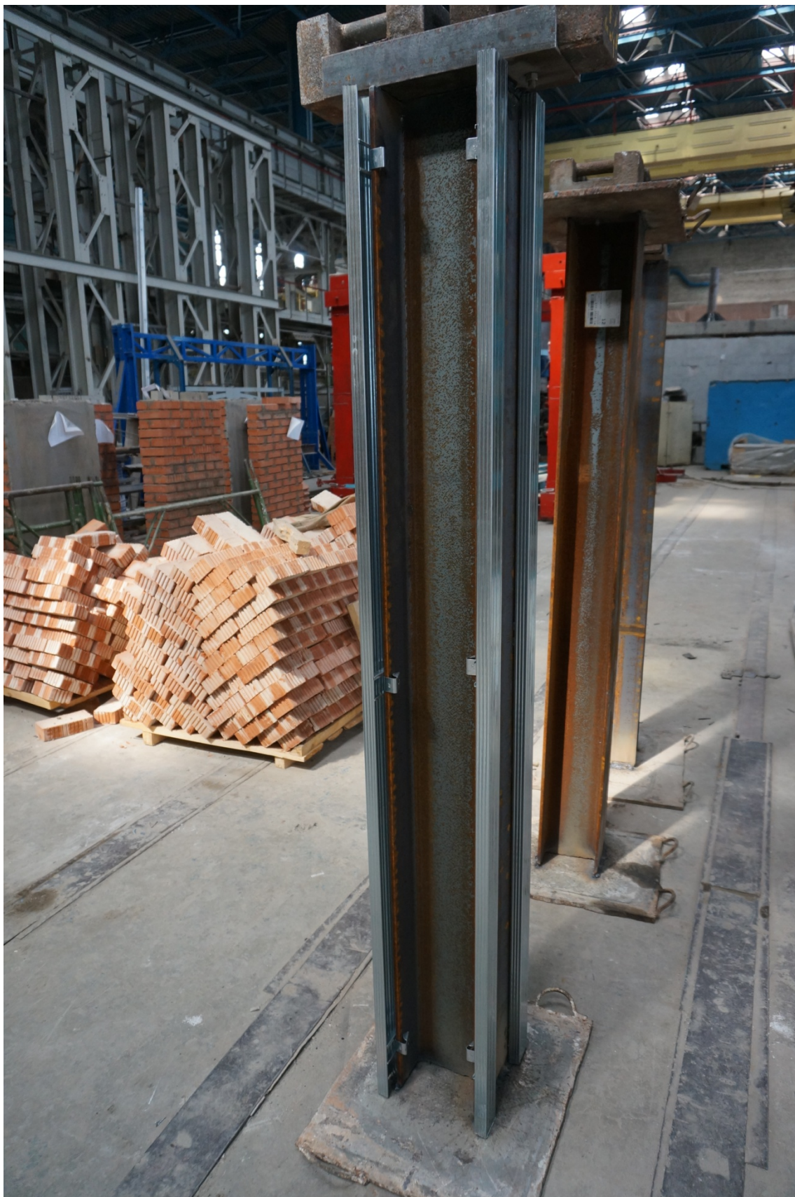
Рисунок 3. КНАУФ - профиль ПП 60/27 установленный на металлическую колонну с помощью зажимов 70x48x42
