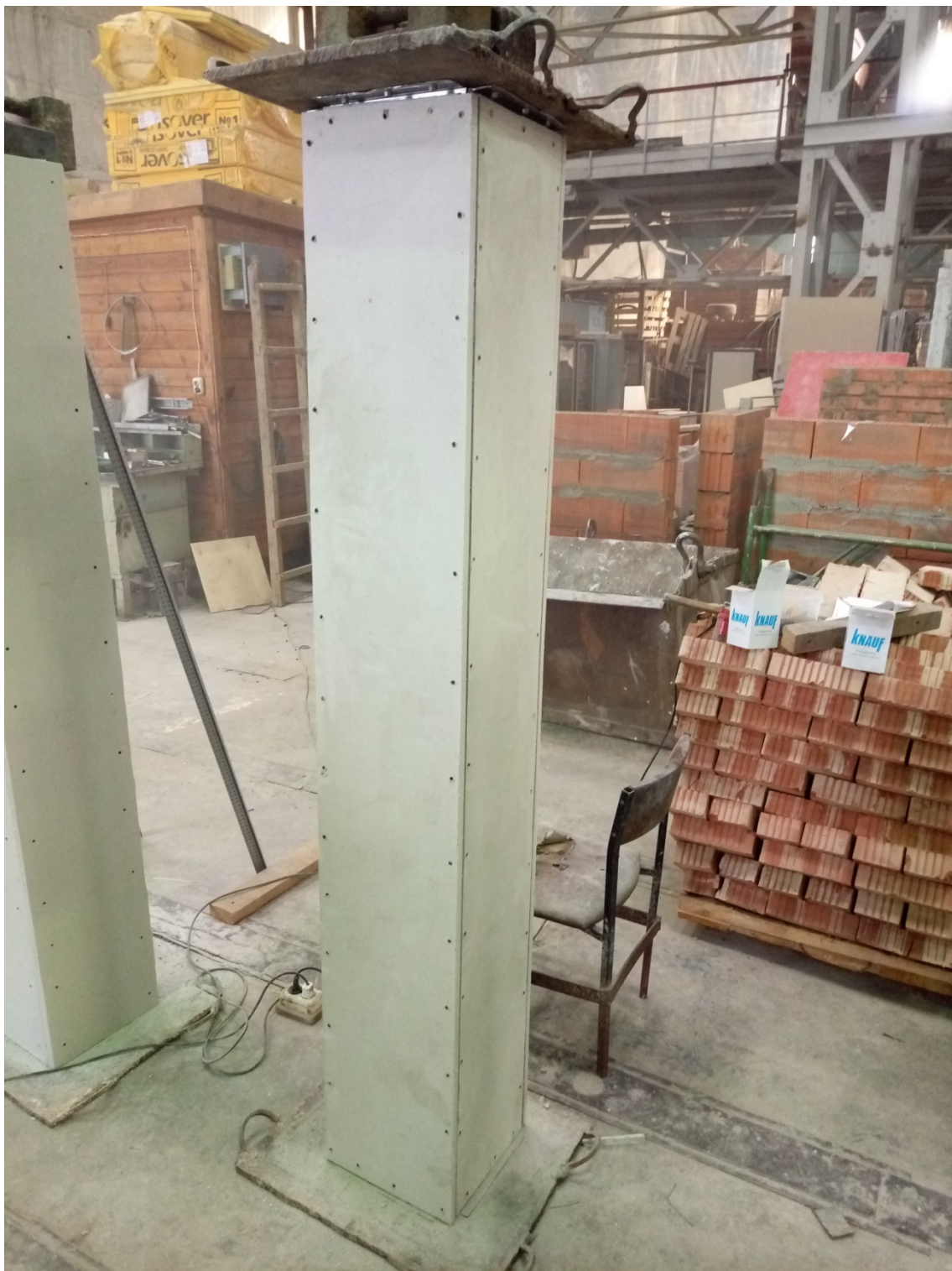
Рисунок 10. Установка в проектное положение двухслойных панелей в бескаркасной облицовке колонн, выполненных из гипсоволокнистых КНАУФ-суперлистов
