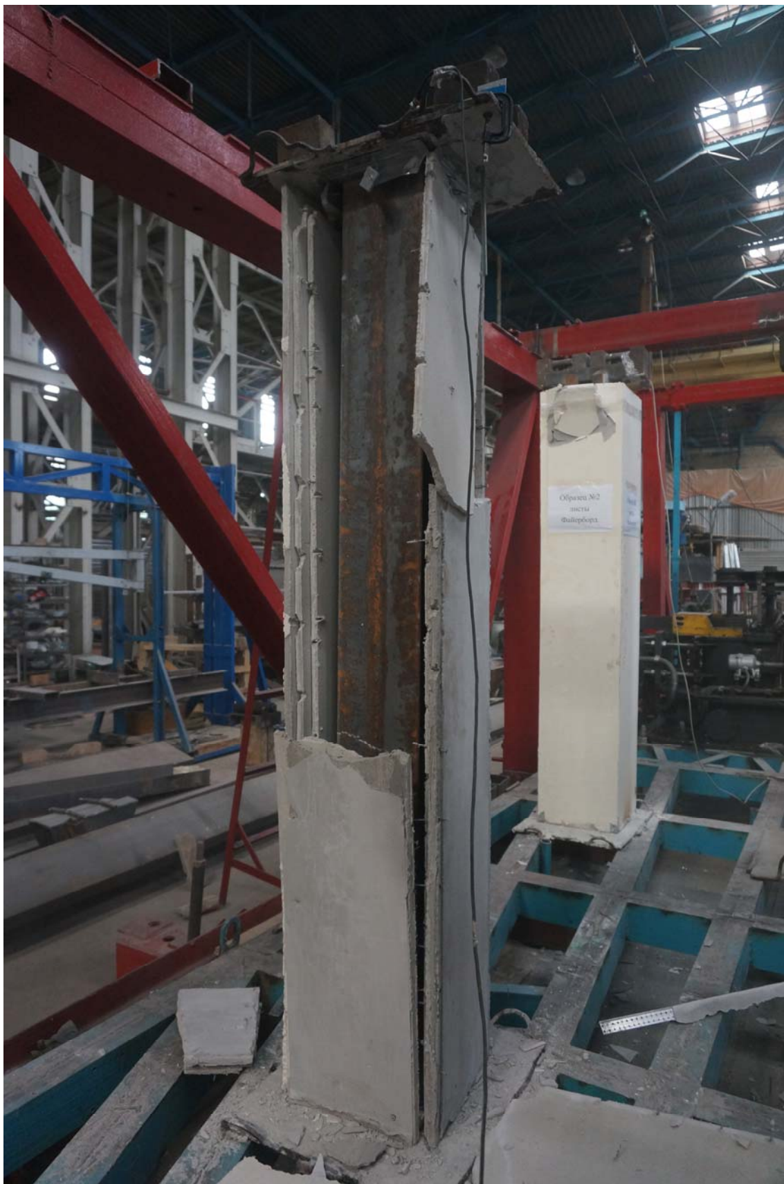
Рис. 18 Характер разрушения облицовки экспериментального образца № 4 (бескаркасная схема крепления облицовки)
