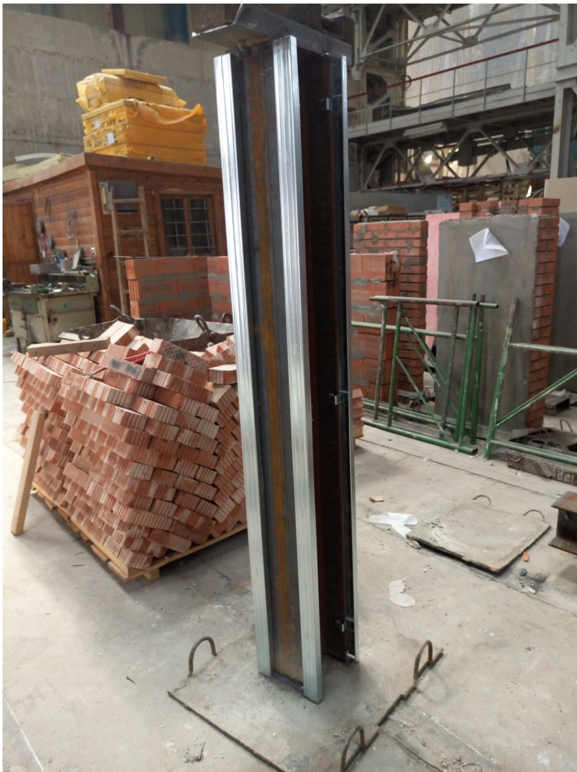
Рисунок 4. КНАУФ - профиль ПП 60/27 установленный на металлическую колонну с помощью зажимов 70x48x42
