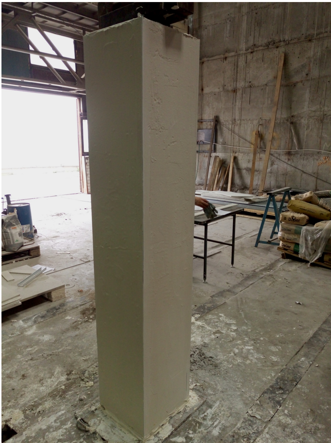
Рисунок 13. Нанесенный выравнивающий шпаклевочный слой по облицовке металлических колонн
