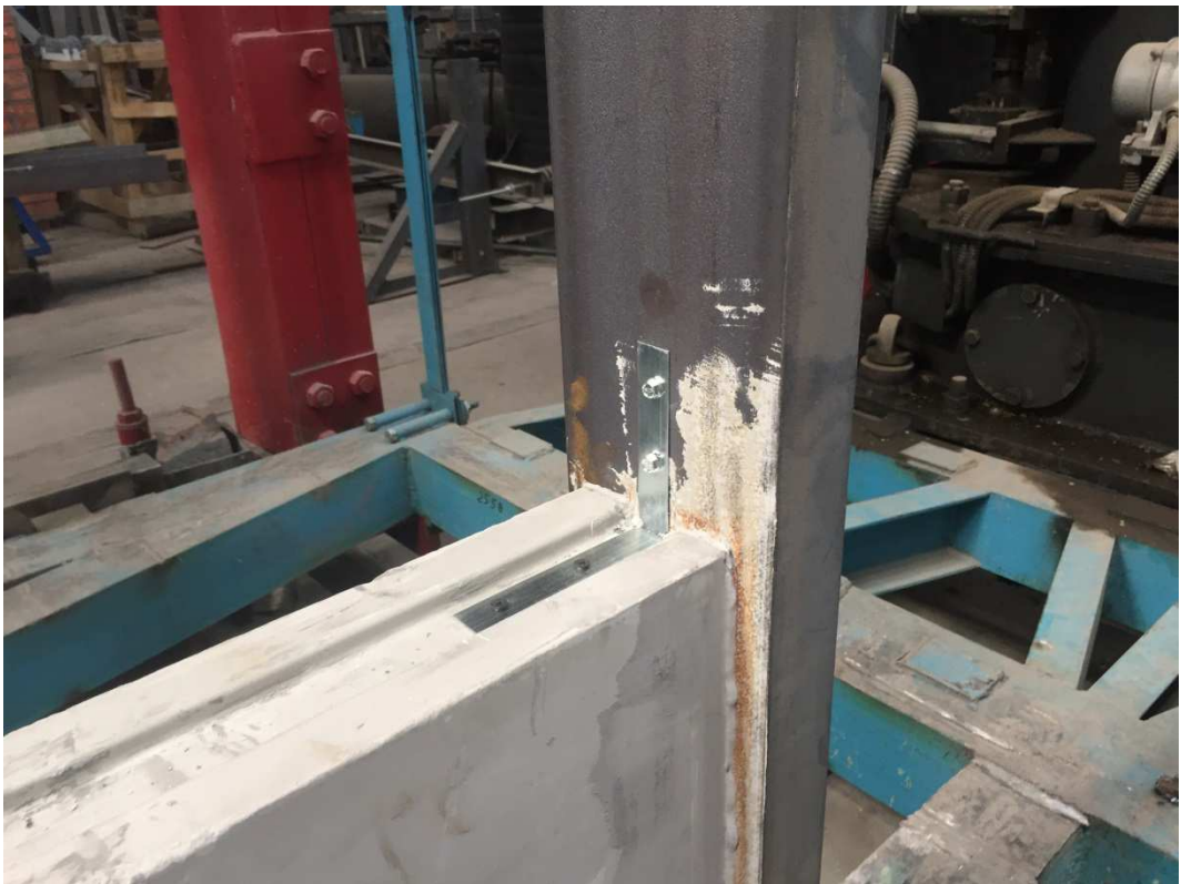
Рисунок 3.3. Элементы крепления перегородки к каркасу
